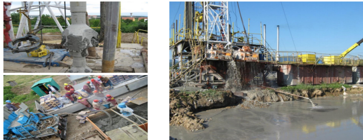
Fig. 7. Execuția forajelor de adâncime
