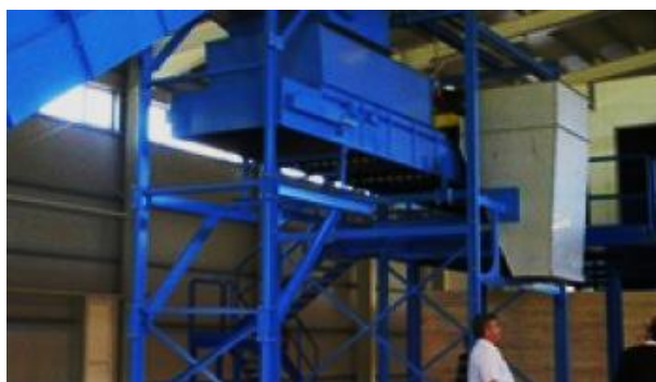
Fig. 2. Stația de sortare de la Brad
