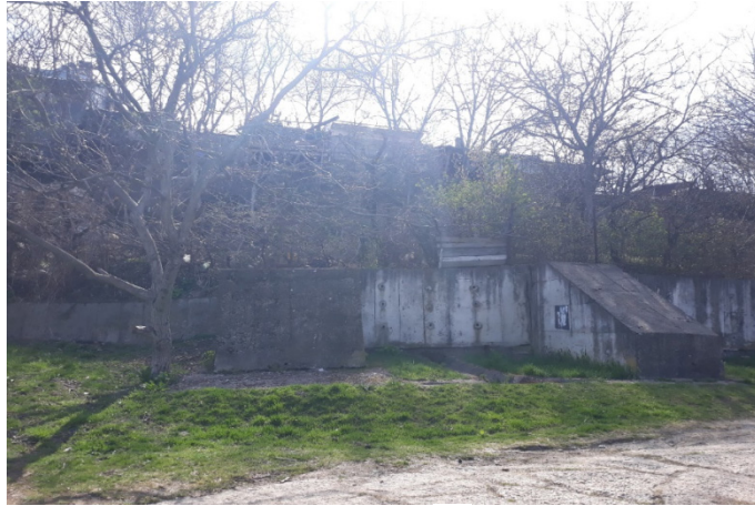
Fig. 5. Lucrări de ranforsare realizate în anii '70, pe strada Poligon
