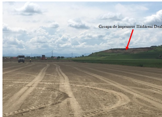
Fig. 4. Sector de drum executat cu material din groapa de împrumut Hădăreni Deal
